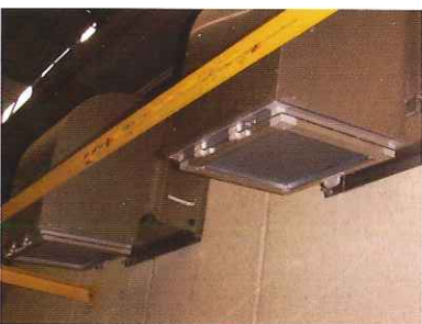
換気口からの侵入防止
