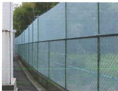
工場周辺フェンス
