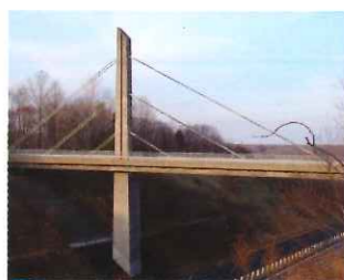
錦岡第3跨道橋耐震補強工事(苫小牧市)
