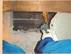
3. 鉄筋の切断
