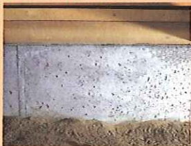
1. 施工前の状態
