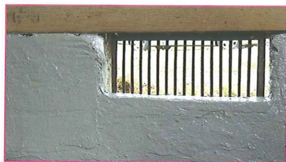
▲補強材POWERアラスト塗布後のコンクリート基礎
