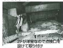
床下の取り付け
