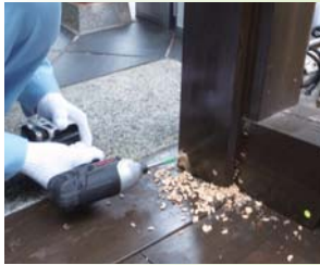
①直径9mm×長さ80mm の穴をあける。
