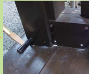
③ハンマーで打設する。
