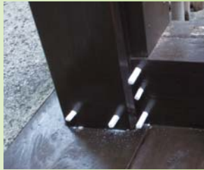
②モクボープラグを挿入する。
